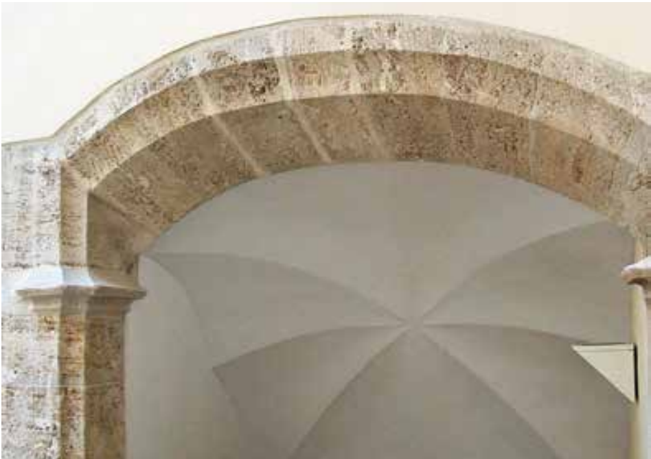
Capialzados con molduras deformadas en los arcos de las escaleras de los palacios de la Generalitat y de Catalá de Valeriola.
